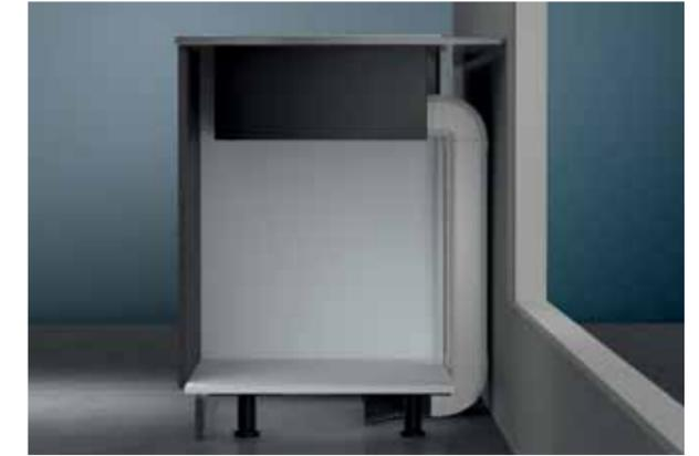
Nel caso di pareti esterne non isolate, invece, si consiglia di adottare un sistema di ricircolo con tubatura parziale o completa per eliminare la formazione di condensa.
